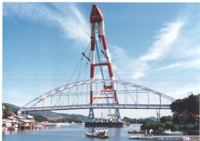
架橋間近の邑久長島大橋
